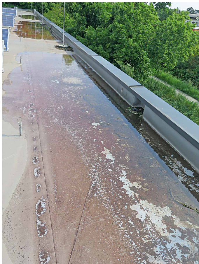
Abb. 11: Pfützenbildung auf einem Flachdach im Randbereich um die Gullys.
