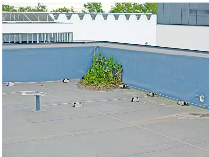
Abb. 12: Bewuchs in einer Ecke eines 2,5 Jahre alten Flachdaches.
