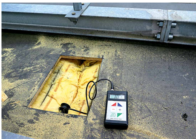
Abb. 6: Öffnung der Dachhaut und eines Daches im beschatteten Bereich unter Vakuumröhrenkollektoren. Die Messung der Holzfeuchte am äußeren Bereich des Trägers ergibt im Mai 2016 10,1 M-% und ist somit unbedenklich.
