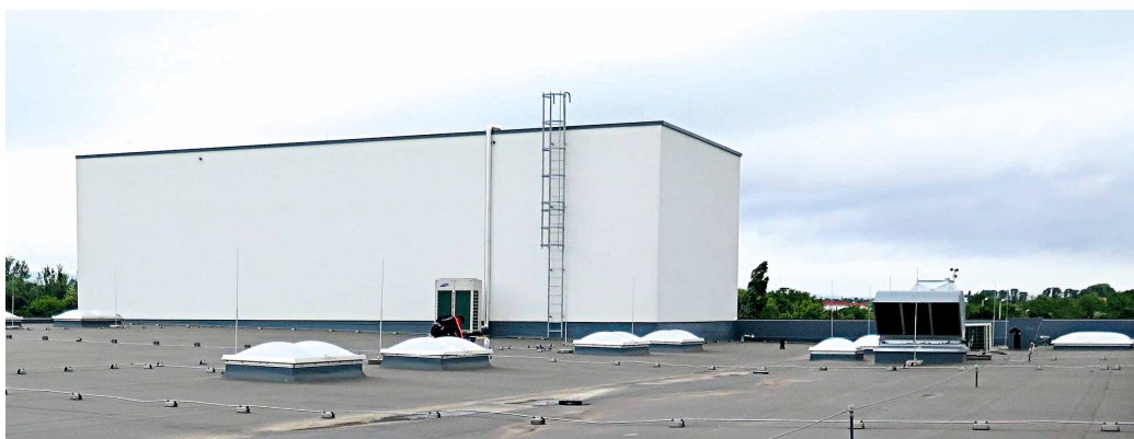
Abb. 5: Beschattung der Dachfläche durch einen höheren Gebäudeteil, eine Klimaanlage, eine Lüftungsanlage und Oberlichtkuppeln.
